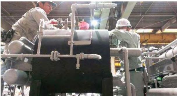
↓ 断熱作業5人くらいで取りかかる。この工期5~6日。
